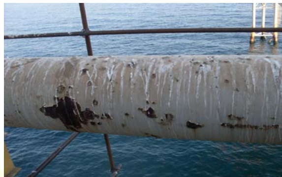
قبل از پوشش دهی
